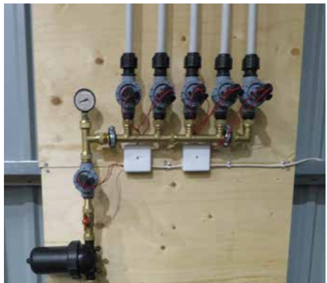
Grenrör 3 Kulventil Inv x inv x inv x inv gänga med lekande mutter x utv gänga
