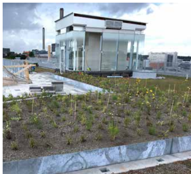
Droppebevattning tak, Värtahamnen i Stockholm
