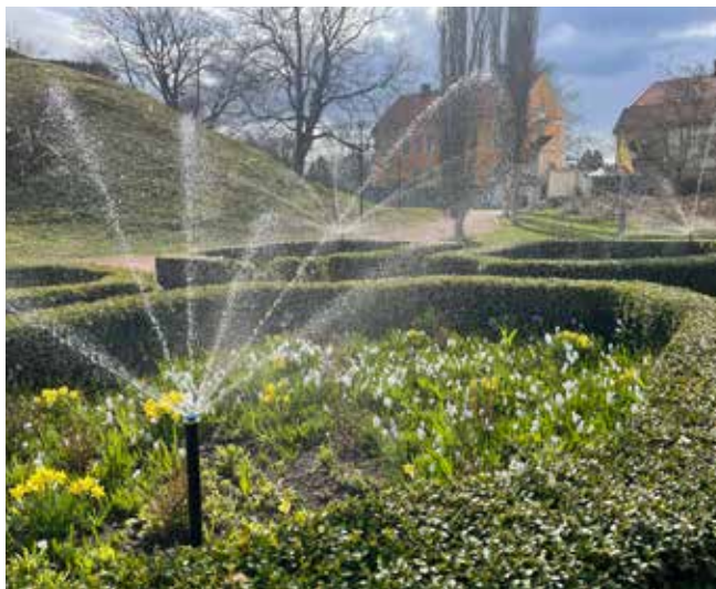
Bevattning med pop-up spridaren MP rotator i slottsparken, Sölvesborg
