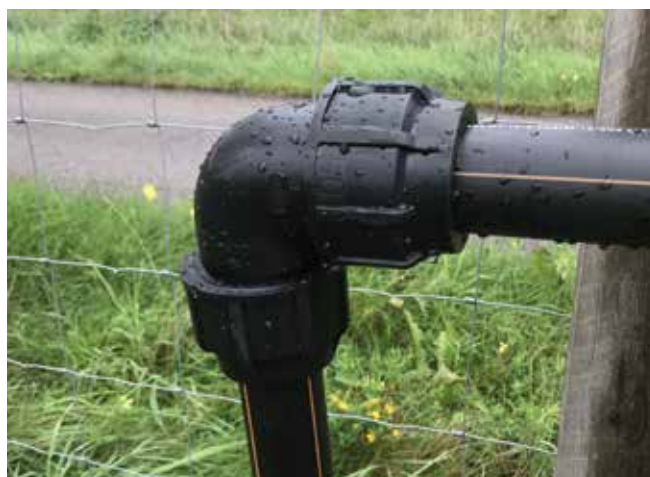
Den vita klämhylsan ska vara intryckt ända till den upphöjda skarven innan man kan föra in slangen helt och hållet i kopplingen
