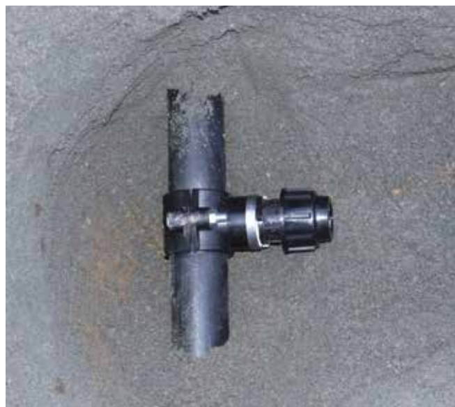
Borra lämpligt hål, gärna med spiralbör. Borra försiktigt så att inte borret går rakt igenom slangen
