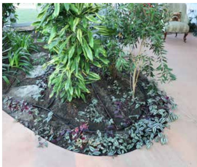
Droppebevattning i planteringar tak, Kv Niagara, Malmö
