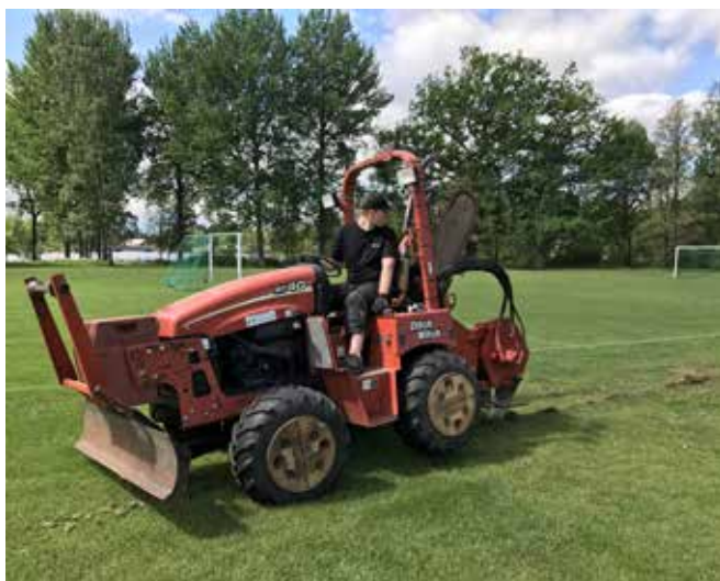
Nedläggning av slang fotbollsplan, Växjö
