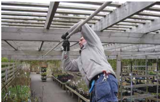
Montering av dysbevattning, Lidens Blommor, Lidköping
