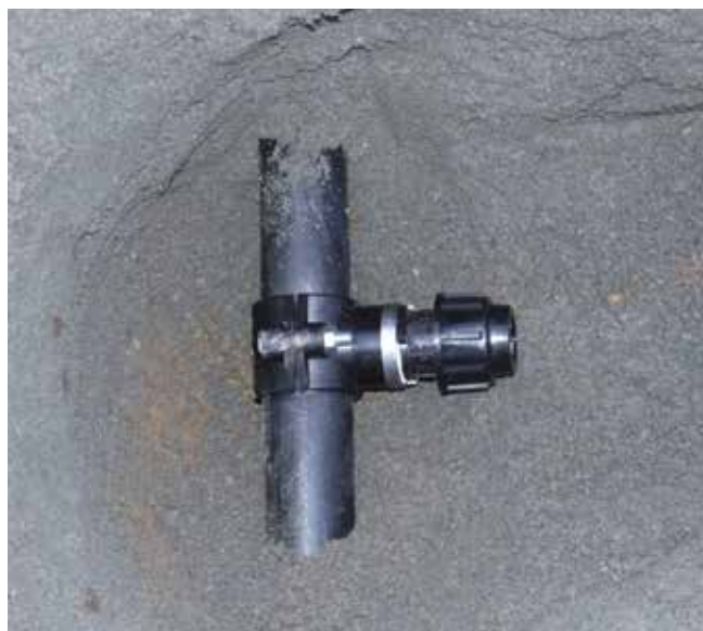
Borra lämpligt hål, gärna med spiralborr. Borra försiktigt så att inte borret går rakt igenom slangen
