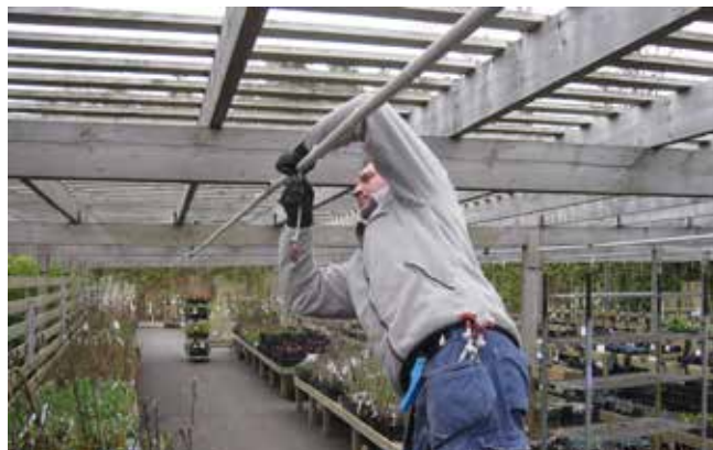
Montering av dysbevattning, Lidens Blommor, Lidköping
