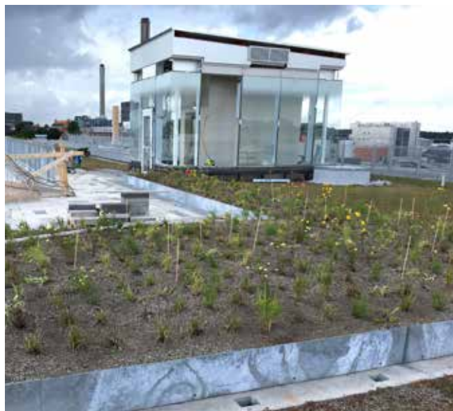
Droppbevattning tak, Värtahamnen i Stockholm
