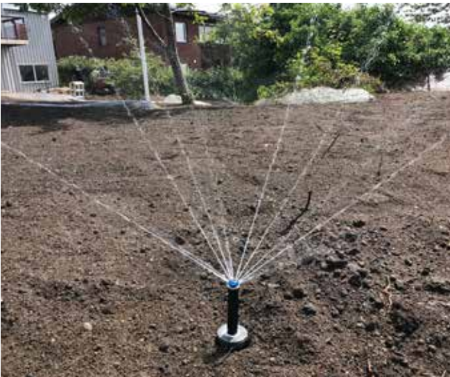
Pop-up bevattning nyanlagd trädgård, Västra Frölunda
