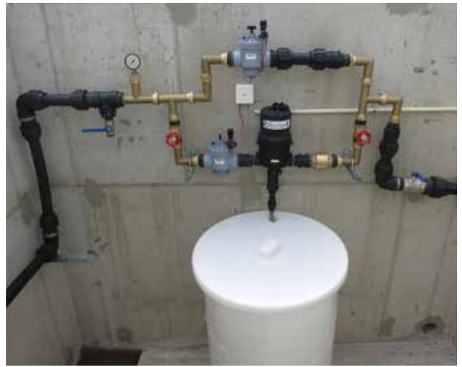
Styrning och näringsdoserare för droppbevattning av nyplanterade träd utmed väg, Sundsvall
