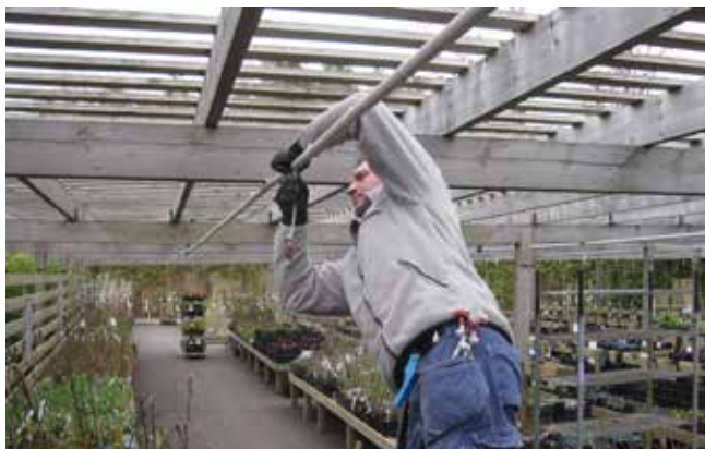
Montering av dysbevattning, Lidens Blommor, Lidköping
