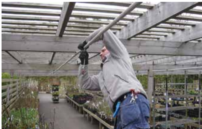
Montering av dysbevattning, Lidens Blommor, Lidköping
