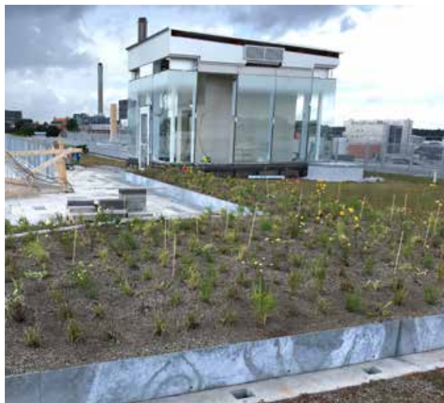
Droppebevattning tak, Värtahamnen i Stockholm
